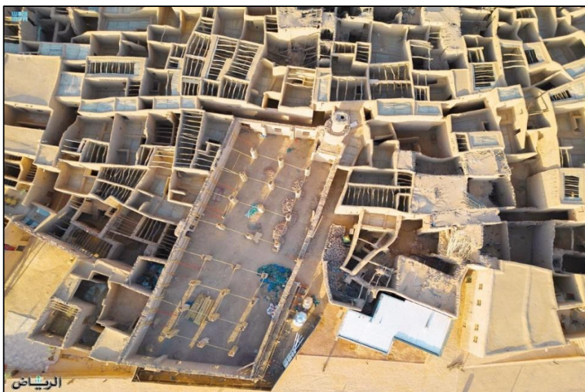
اللوحة 3: أعمال تطوير ما يُسمى بمسجد العظام في البلدة القديمة ضمن مشروع الأمير محمد بن سلمان لتطوير المساجد التاريخية. (وكالة الأنباء السعودية 2023).
